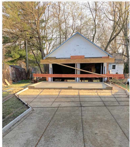
Garage slab poured; rebar laid for driveway pour
